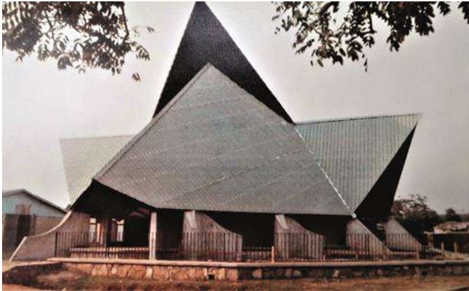
Nieuwe Parochiekerk St. Mathias (Centr. Afr. Rep.) Constructie: N. Hettinga, Installatie: P. Vaas
